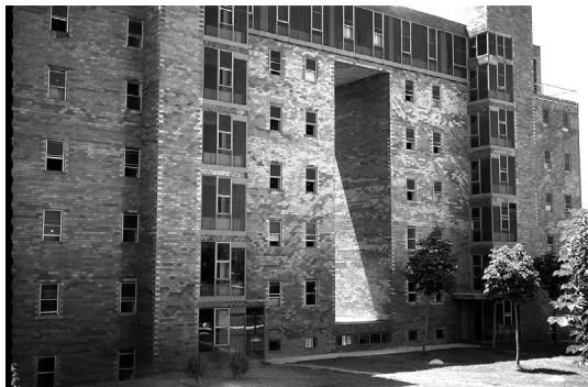
35. Edificio de dormitorios. Colegio mayor César Carlos. Archivo de la FAS
