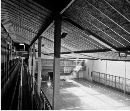
31. Interior del gimnasio Maravillas. Archivo de la FAS
