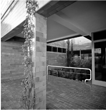
44. Revestimiento cerámico en fachada y pavimento en la entrada al edificio social. Colegio mayor César Carlos. Archivo de la FAS
