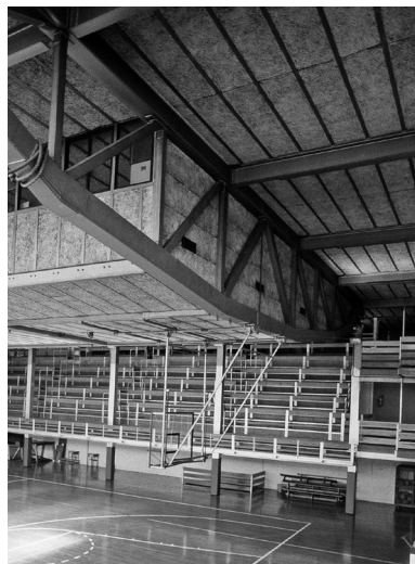
29. Interior del gimnasio con la cercha en primer término. Archivo de la FAS
