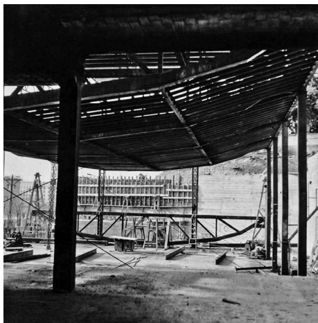
28. El gimnasio Maravillas en construcción. Archivo de la FAS
